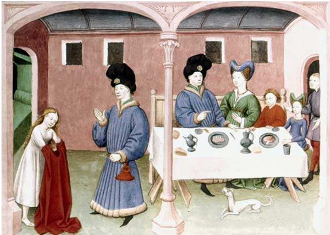
Ryc. 45. Spożywanie posiłku przy użyciu zastawy cynowej.
